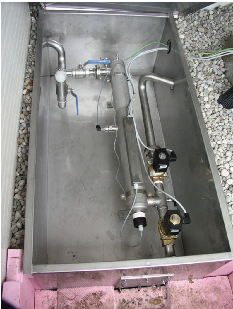
Abb.18: UV-Desinfektionsanlage © Reiter u. a., WVA (Plainfeld)
