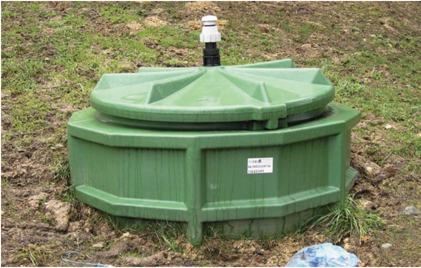
Abb. 16: Quellsammelschacht aus Kunststoff, © AGES
