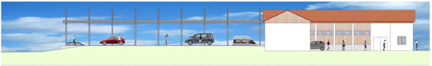
Ansicht des umgebauten Abfallsammelzentrums aus Richtung Handwerkerzentrum
