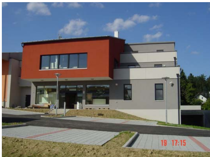
Apotheke Hitzendorf steht kurz vor Fertigstellung
