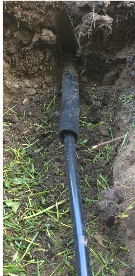
Bestandsrohr am Grundstück
