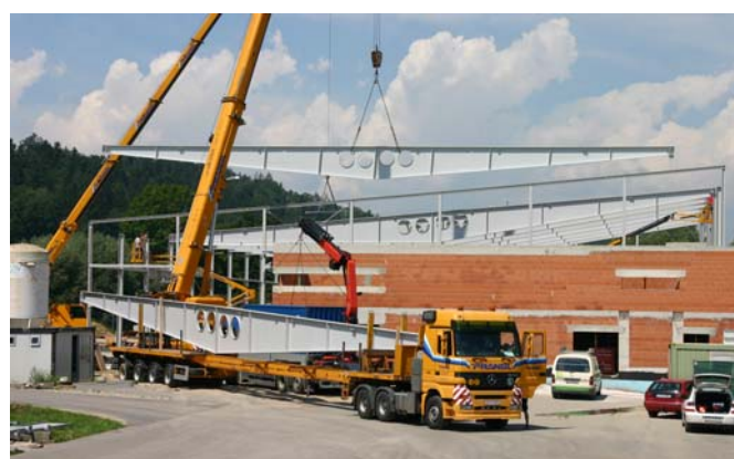
Antransport und Montage der 35 m langen und 9 t schweren Stahlträger für das Stahlgerippe
