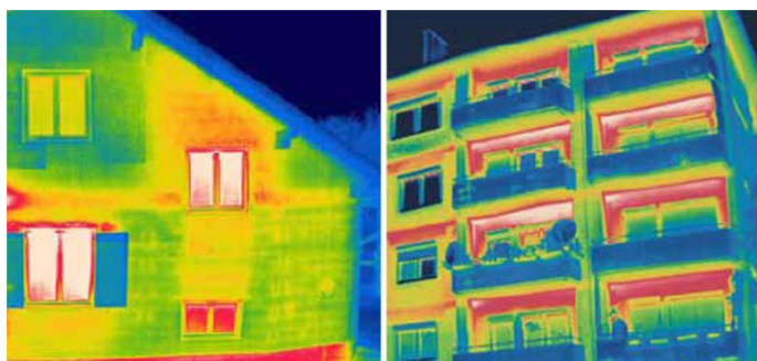
Thermische Schwachstellen bei einem Ein- und einem Mehrfamilienhaus
